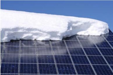
Wenn nun große Schneemassen auf den Modulen bzw. der PV-Anlage liegen, dann entwickeln diese einen **enormen Druck**.
