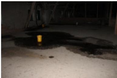
Durch die Ziegelbrüche dringt bei abtauemdem Schnee oder durch Regen Wasser ein und verursacht einen **Nässeschaden**. Diese Schäden bewegen sich je nach Gebäude schnell im hohen **fünfstelligen Bereich**.
